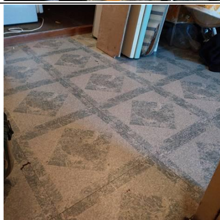
Photo n° PhA004 Localisation : Atelier; Pièce 1 Ouvrage : 5 - Planchers et planchers techniques - Revêtements de sols Partie d'ouvrage : Dalle de sol Description : Dalle de sol Localisation sur croquis : MPSCA004
